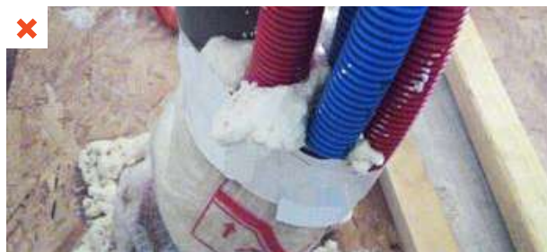
Mauvais traitement de la traversée du plan d'étanchéité à l'air d'un plancher bas. ©AQC
