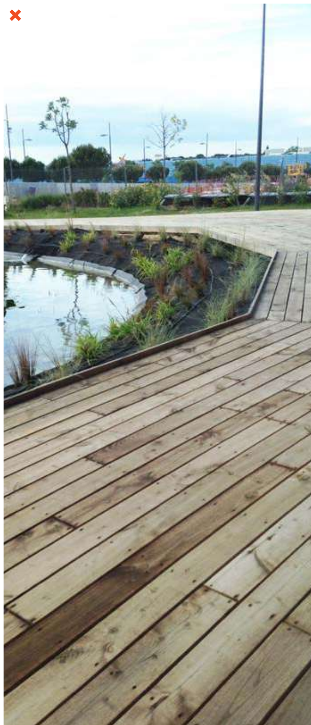
Exemple d'un platelage bois lisse et en pente pouvant devenir glissant. ©AQC
