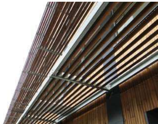
Exemple d'une solution corrective : installation de protections solaires pour limiter les apports solaires. ©AQC
