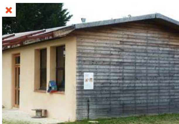
Bardage directement en contact avec un sol humide : non-respect du DTU avec risque de remontée capillaire. ©AQC
