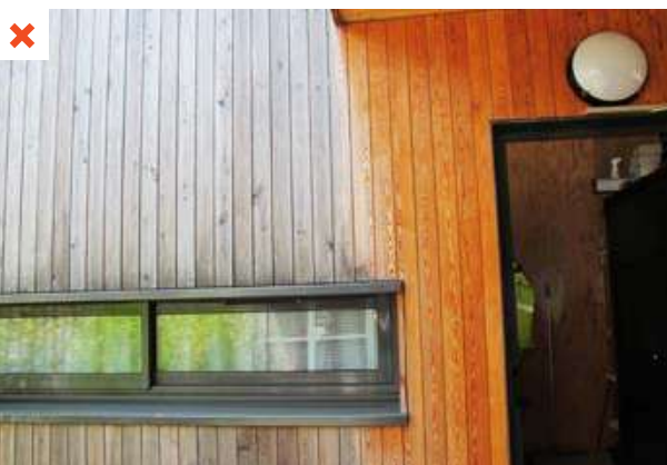
Bois qui grise non uniformément à cause d'accidents de façades. ©AQC
