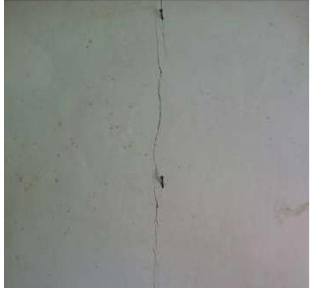
14. Fissuration au droit d'un poteau de structure suite à un défaut d'enrobage
